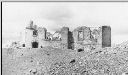
1918 - 1950 Zerstörung, Wiederaufbau, Katastrophe von 1949 Treppenhaus zur 4. Etage
